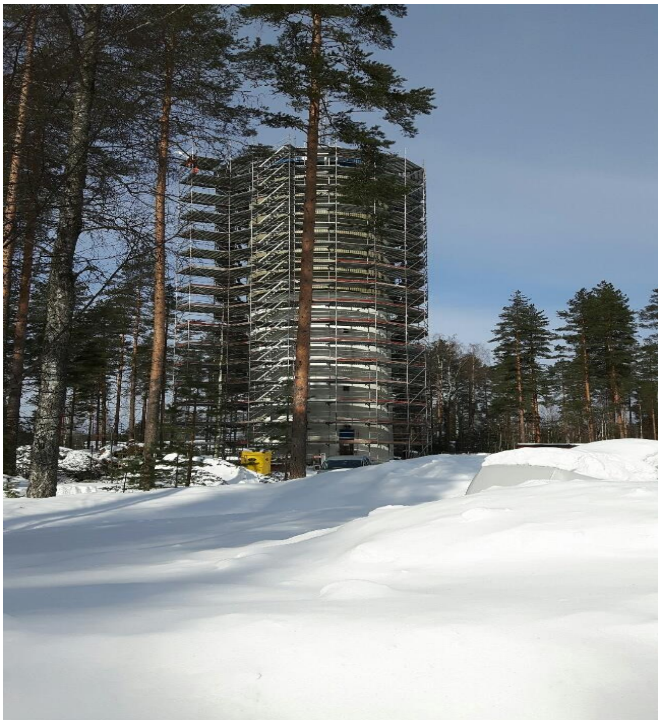
Ylämyllyn vesitornin saneeraustyö alkoi maaliskuun alussa telineitten pystyttämisellä
