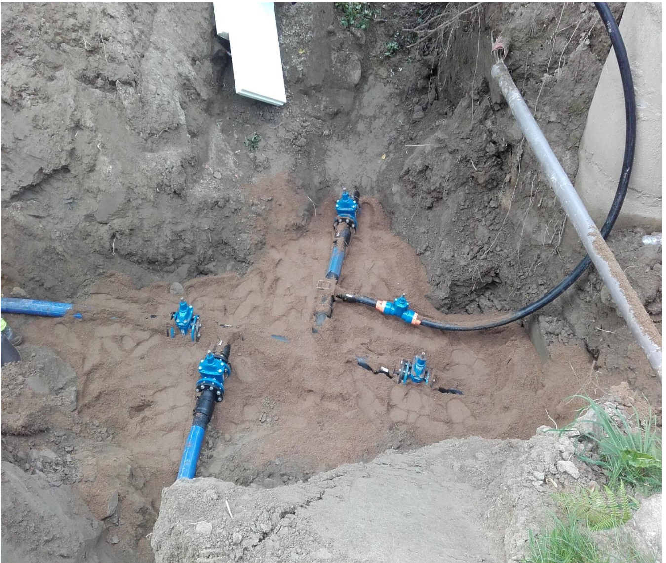
Viinijärven taajaman keskusta-alueella uusittiin pääsääntöisesti 1960-luvulla rakennettua valurautaista vesijohtoverkosta lähes 2 km.
