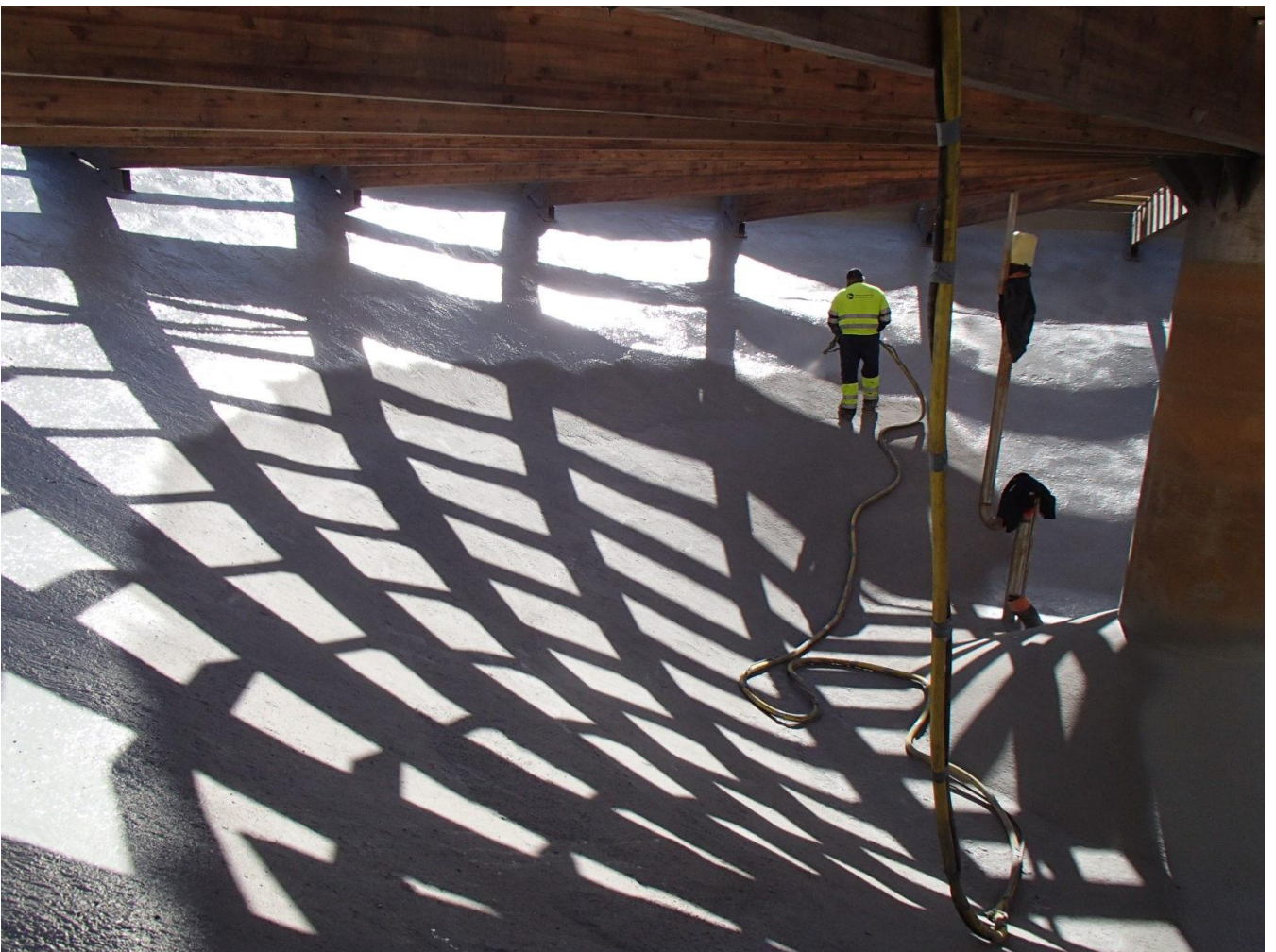
Keväällä 2014 saneeratun Viinijärven vesitorin säiliöosan pinnoitustyö käynnissä
