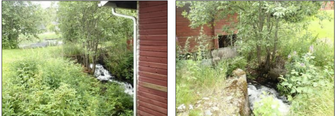
Kuva 14. Lampi, silta ja patorakennelma taustalla, myllyrakennus etualalla (vasen). Silta ja patorakennelma etualalla, taustalla myllyrakennus (oikea). Valokuvat © Mikroliitti Oy 2020.
