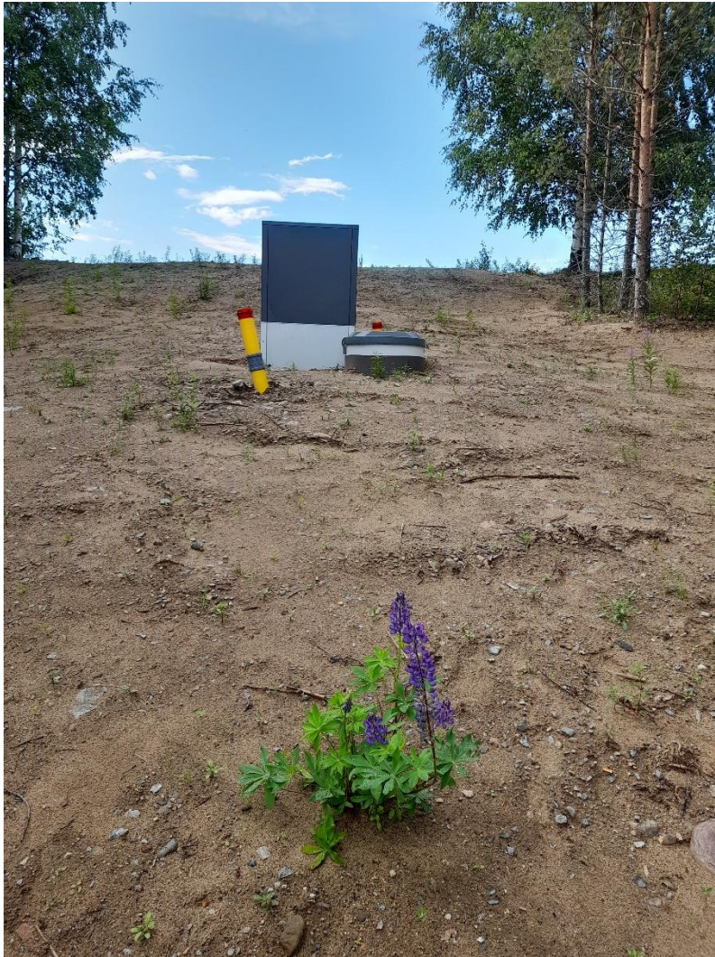
Kuva 21. Yksi lupiiniverso Ruostelahden rakennetun jätevesikaivon luiskassa.
