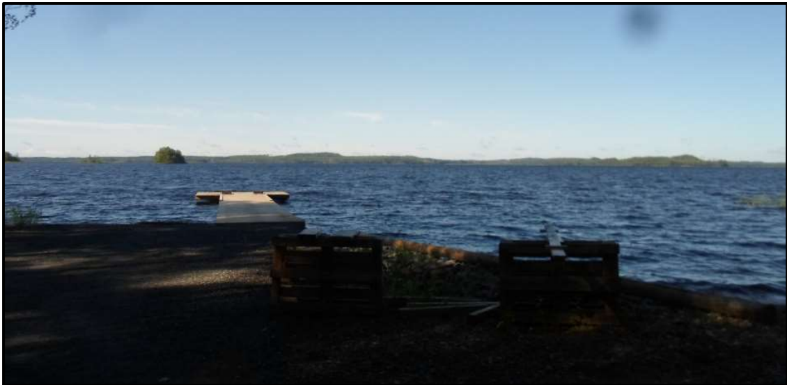
Kuva 15. Alueelle on jo rakennettu laituri.
