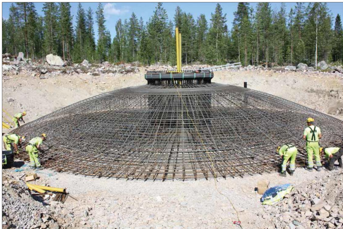
Kuva 3-5. Maanvarainen teräsbetoniperustus raudoitettuna ennen betonivalua.
