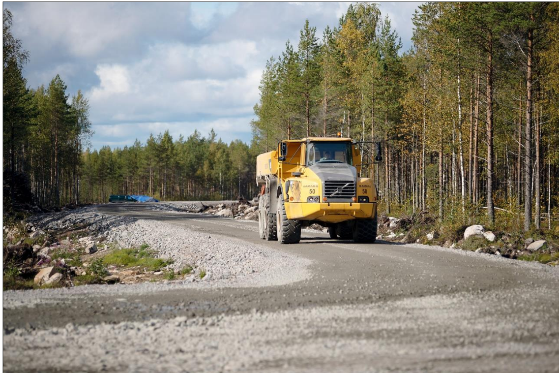
Kuva 3-7. Esimerkkikuva tuulivoimalan rakenteilla olevasta huoltotiestä (Kuva: OX2).
