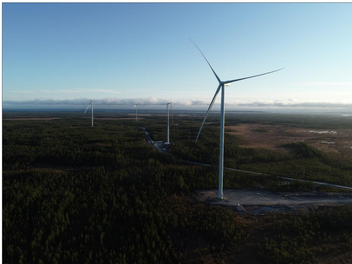
Kuva 3-3. Kuva lieriötornirakenteisesta tuulivoimalasta (Kuva: OX2).
