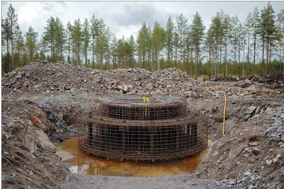
Kuva 3-6. Esimerkkikuva kallioankkuriperustuksesta (Kuva: OX2).
