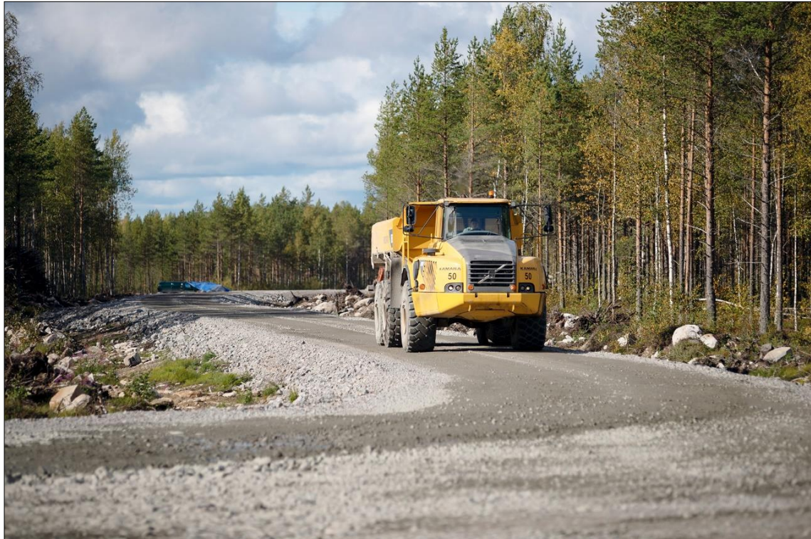
Kuva 6-7. Esimerkkikuva tuulivoimalan rakenteilla olevasta huoltotiestä (kuva: OX2).
