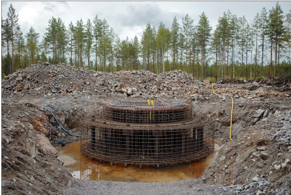
Kuva 6-4. Kallioankkuriperustus (Kuva: OX2).
