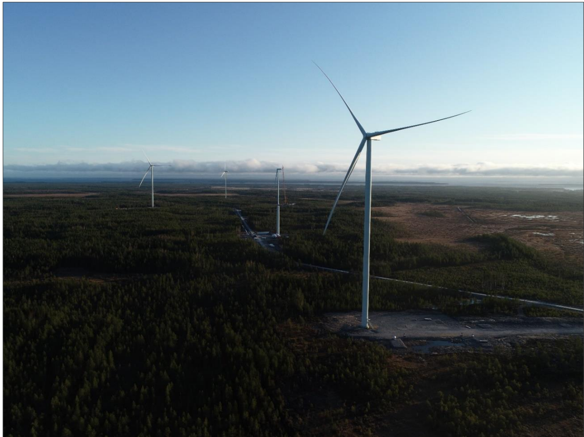
Kuva 5-2. Esimerkkikuva lieriötornirakenteisesta tuulivoimalasta (kuva: OX2).
