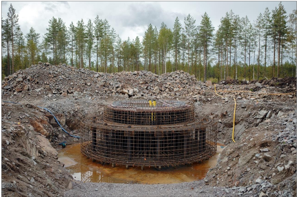
Kuva 5-5. Esimerkkikuva kallioankkuriperustuksesta (kuva: OX2).
