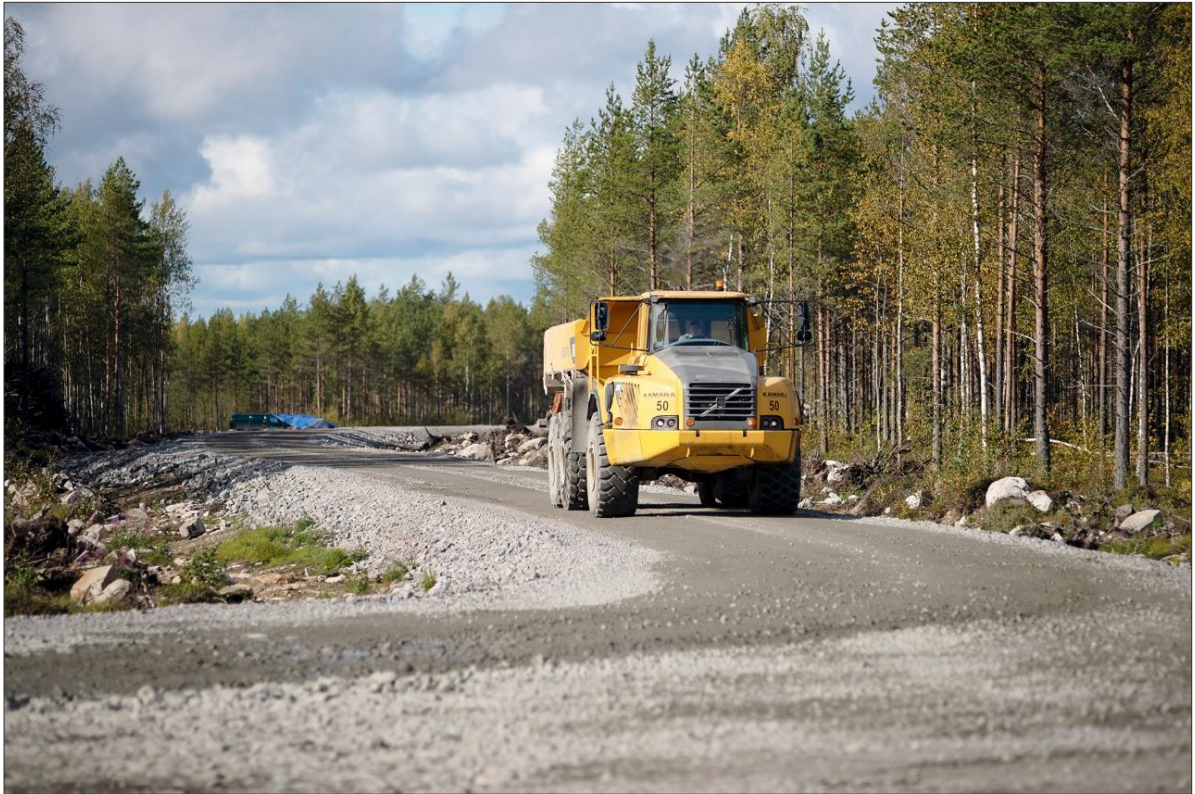
Kuva 5-8. Esimerkkikuva tuulivoimalan rakenteilla olevasta huoltotiestä (kuva: OX2).
