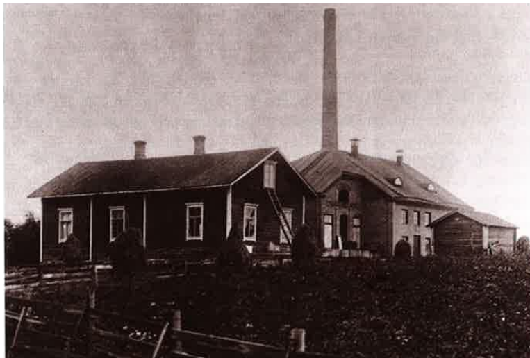
Kuva 6. Suojeltu Osuusmeijerin rakennus valmistui vuonna 1906. Vuosien saatossa rakennuskompleksi on muuttunut melkoisesti, mutta paikka on säilynyt samana. (Lähde: Liperin rakennettua kulttuuriympäristöä 2015 – FCG Arkkitehdit, FCG Suunnittelu ja tekniikka Oy)
