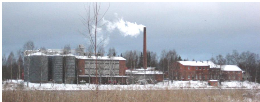
Kuva 8. Paikallisesti arvokkaan Osuusmeijerin alueen rakennuskanta, Kesäkuun alussa 5.6.2020 palanut myllyrakennus on kuvassa vasemmalla (Lähde: Liperin rakennettua kulttuuriympäristöä 2015 – FCG Arkkitehdit, FCG Suunnittelu ja tekniikka Oy)
