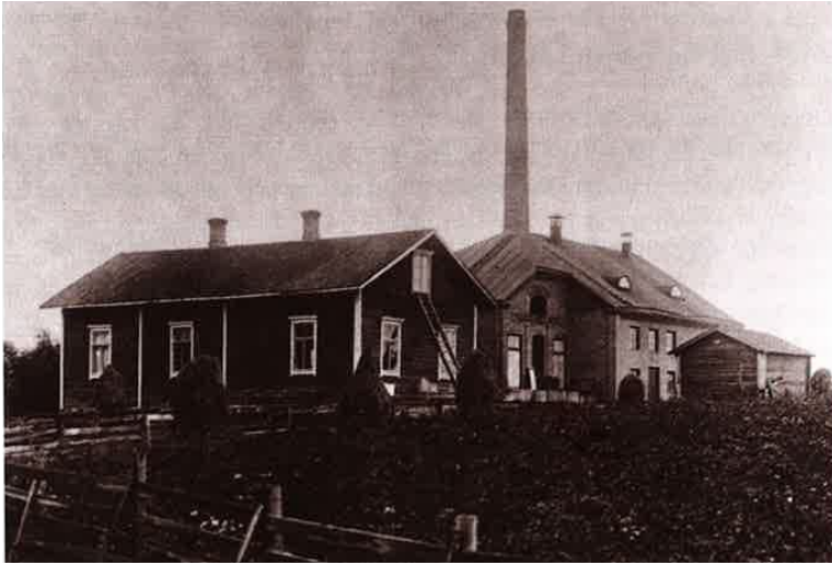
Kuva 7. Suojeltu Osuusmeijerin rakennus valmistui vuonna 1906. Vuosien saatossa rakennuskompleksi on muuttunut melkoisesti, mutta paikka on säilynyt samana. (Lähde: Liperin rakennettua kulttuuriympäristöä 2015 – FCG Arkkitehdit, FCG Suunnittelu ja tekniikka Oy)
