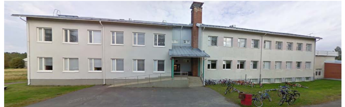
Vuoden 2009 syyskuulta oleva kuva edustaa aikaa, jolloin koulu toimi vielä lukiona. Koulurakennus on nykyisin perusopetuksen käytössä. (Lähde: Google Maps.)
