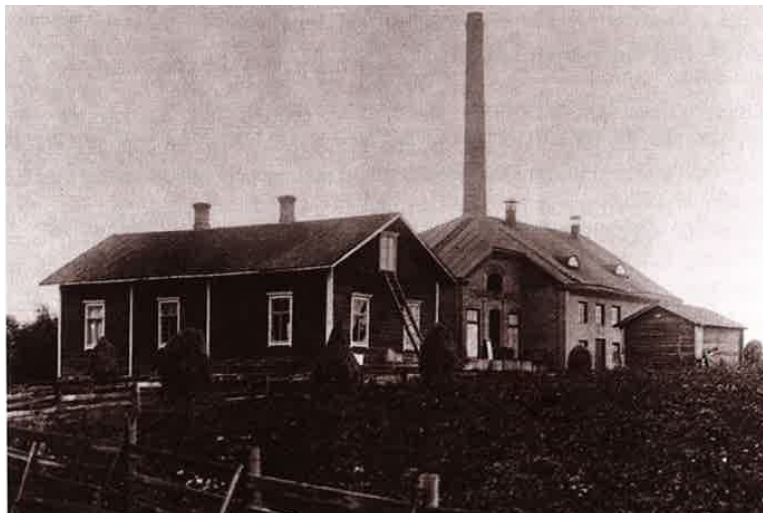
Kuva 6. Suojeltu Osuusmeijerin rakennus valmistui vuonna 1906. Vuosien saatossa rakennuskompleksi on muuttunut melkoisesti, mutta paikka on säilynyt samana. (Lähde: Liperin rakennettua kulttuuriympäristöä 2015 – FCG Arkkitehdit, FCG Suunnittelu ja tekniikka Oy)
