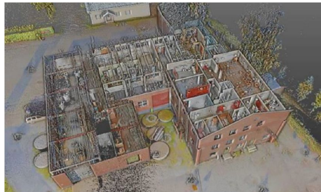
Kuva 9. Vasemmalla suunnittelualueella sijaitseva puinen asuin/toimistorakennus kuvattuna kesällä 2021. Oikealla 3D-laserkeilauskuva Meijerirakennuksesta vuodelta 2021, kuvankäsittely Autodesk ReCap. Lähde: Liperin myllymiljöön suppea rakennushistoriallinen selvitys, Aavakax Oy,
