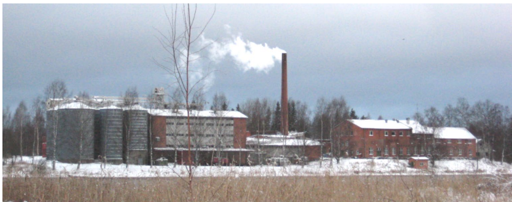
Kuva 9. Paikallisesti arvokkaan Osuusmeijerin alueen rakennuskanta, Kesäkuun alussa 5.6.2020 palanut myllyrakennus on kuvassa vasemmalla (Lähde: Liperin rakennettua kulttuuriympäristöä 2015 – FCG Arkkitehdit, FCG Suunnittelu ja tekniikka Oy)
